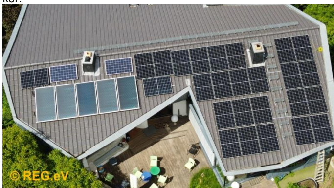
Bild: Aufnahme der Selbstbau-PV-Dachanlage bei einer ungewöhnlichen Dachform in Roßdorf mit vereinseigener Fotodrohne
